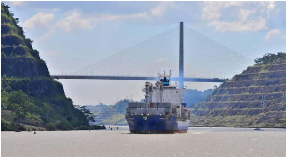
Den nya Centennial bridge över kanalen vid Culebra Cut. Bils från Google.
